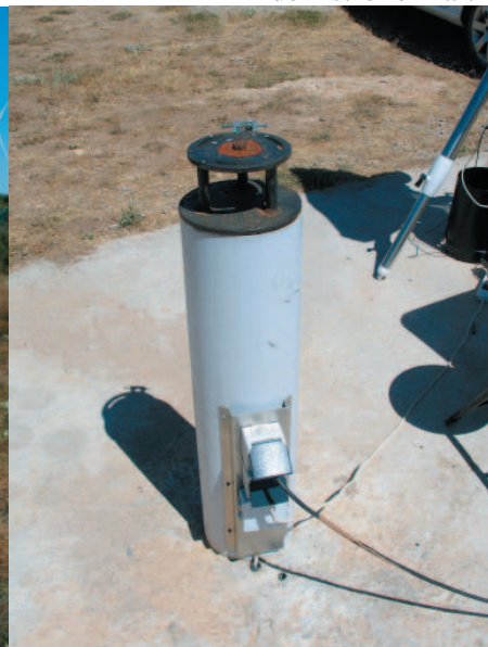
FOTO 6.- MODELO DE COLUMNA DE CEMENTO CON TERMINACIÓN EN HIERRO PARA COLOCAR LA MONTURA Y TOMA DE CORRIENTE. (FOTO A. REQUENA)
