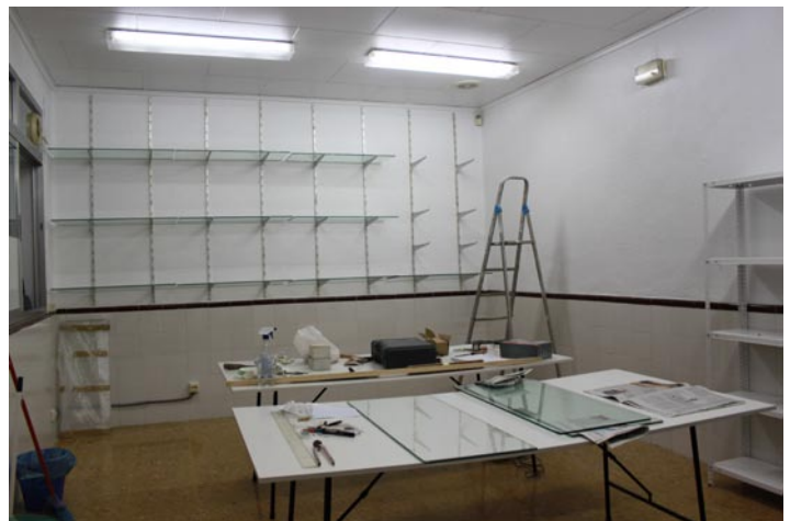
LAS ESTANTERÍAS YA CASIS TERMINADAS...
