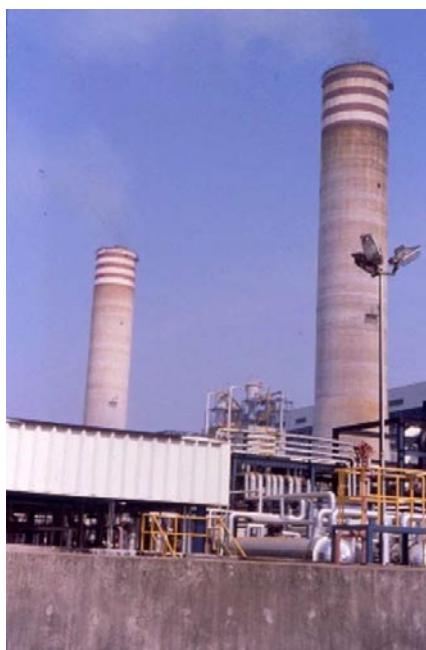
FIGURA 2.- PLANTA TERMOELÉCTRICA II
